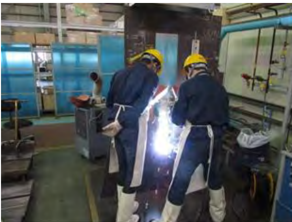
縦向き自動溶接
