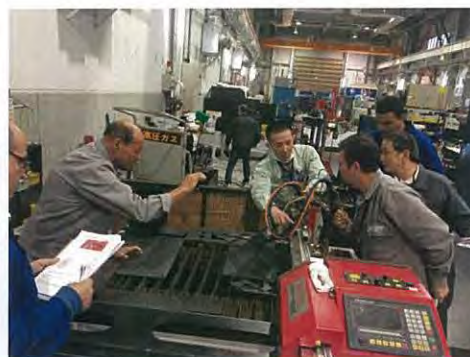
[PNC-12 のケーブル接続]
