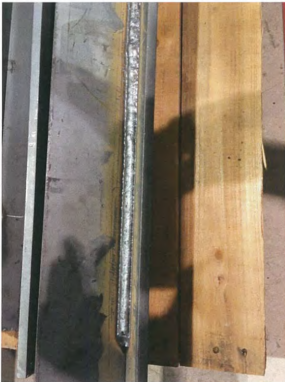
[WEL-VERT による上進溶接の溶接面]
