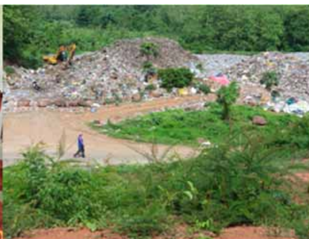
ルアンプラバン市最終処分場
