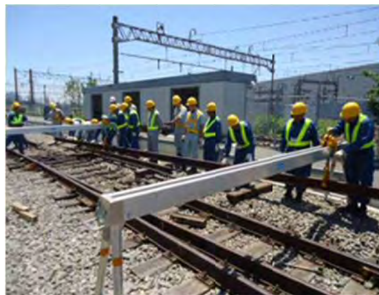
レール交換の実習 （JR東日本東京支社訓練センター）
