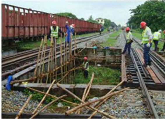
橋梁上の作業
