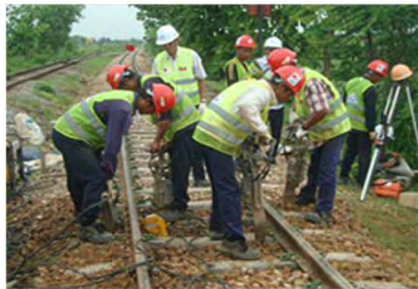
突き固め作業
