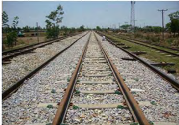
50Nレール交換後の軌道
