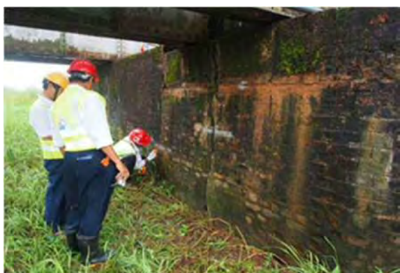
下部工の目視検査
