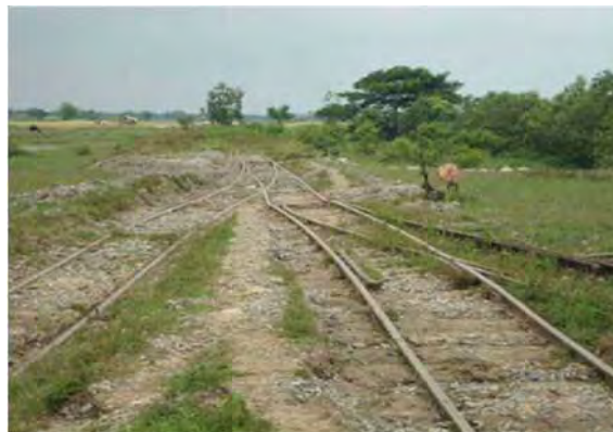
大きな地盤変位が発生していても使用している分岐器
