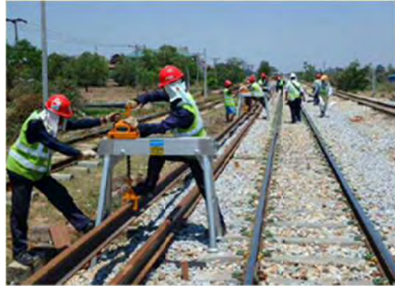
50Nレールへの交換
