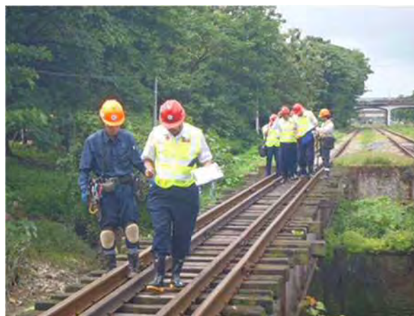
9番橋梁の検査の着眼点訓練
