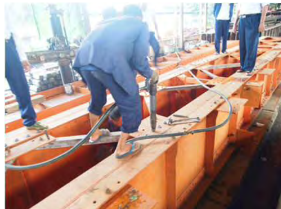
リベット打ち作業
