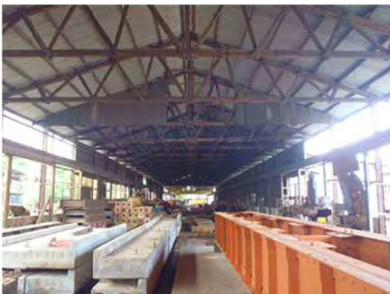
工場内の状況
