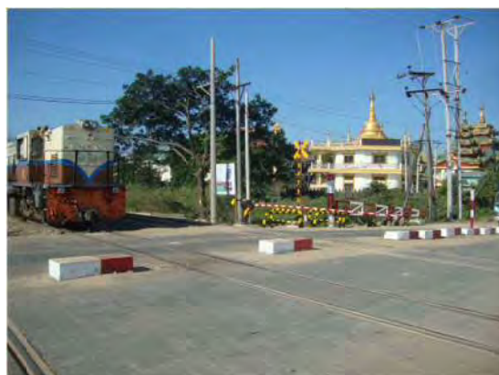
チャンシッター踏切(自動警報装置、遮断機)
