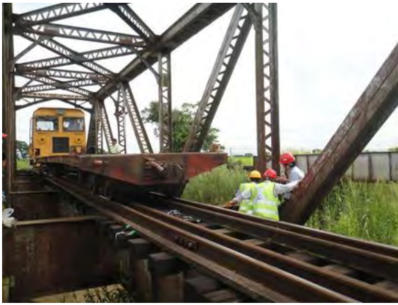
(1) 応力測定訓練 (No32 Bridge) (2) 橋脚に近接した検査 (No21 Bridge)
