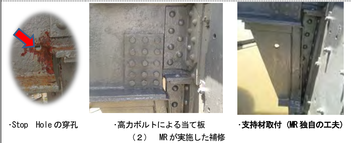
図 4 - 2 No13 Bridge (2) の補修状況
