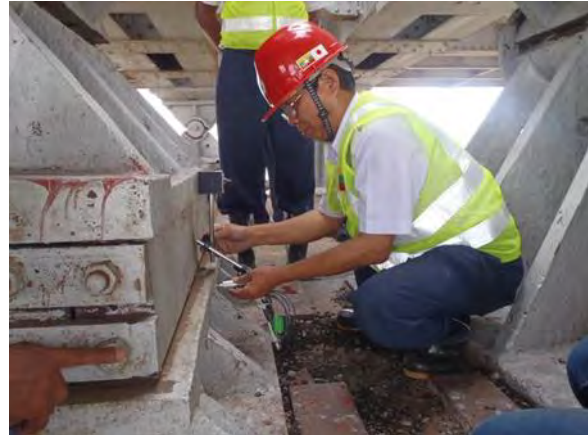
(4) Inwa Bridge 検査方法の訓練
