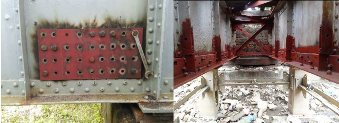
写真 4-3 MR 実施概要 Phase 2 (補修工事)
