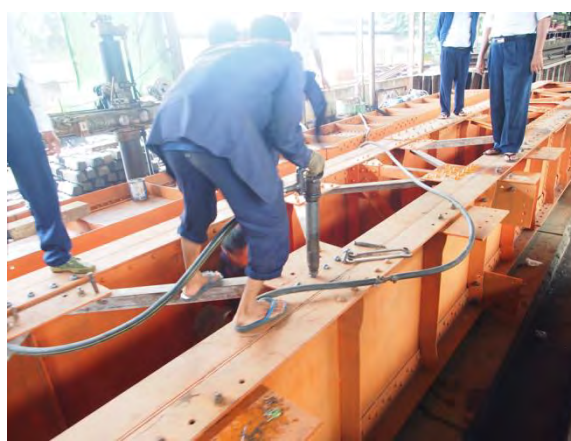
(4) リベット打ち作業
