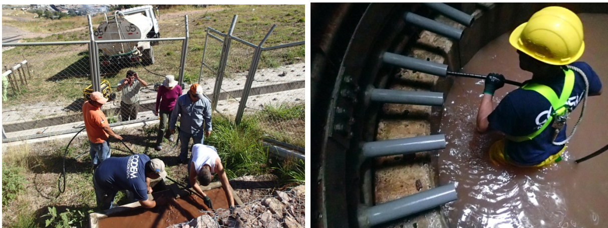
Figura 11 Eliminación de obstrucciones en la obra de drenaje horizontal (Fuente: JCT)
