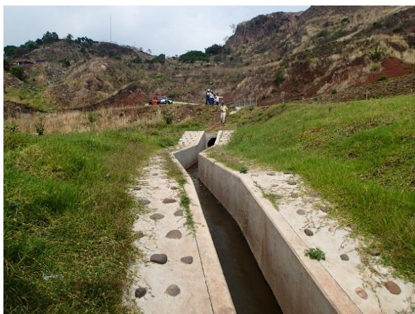
Canal abierto de agua superficial
