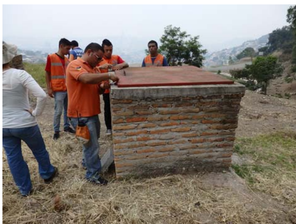
Caja de protección de instrumentos
