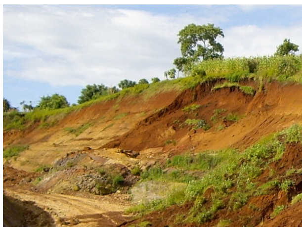
Desmoronamiento de la capa superficial del talud.
