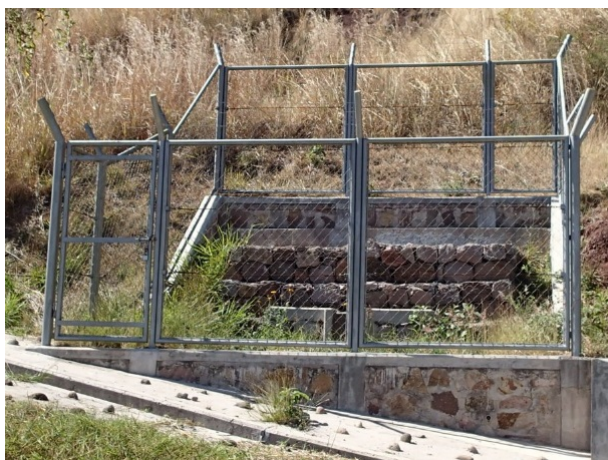
Muro de protección de la boca del orificio a base de gaviones
