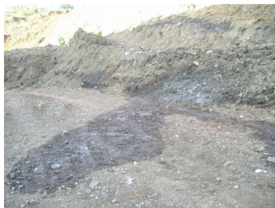
Agua brotando desde un talud creado por excavación
