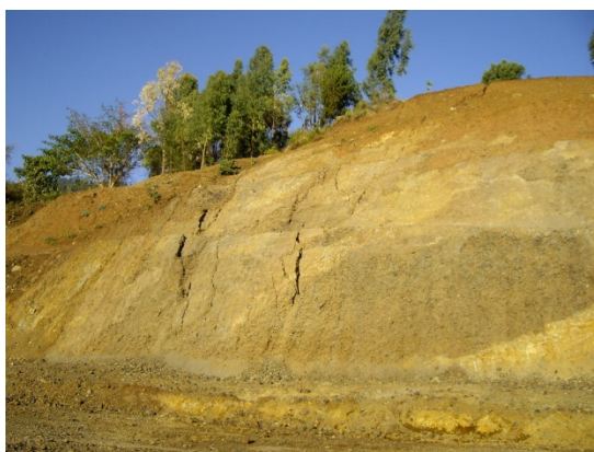
Grietas en la superficie del talud creado por excavación por remoción de tierra.
