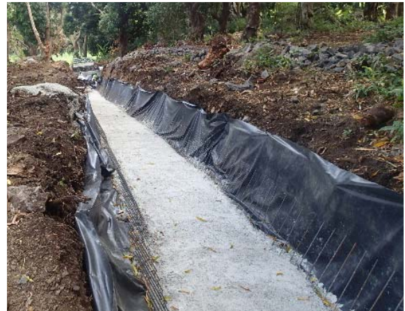
Canal con membrana impermeable
