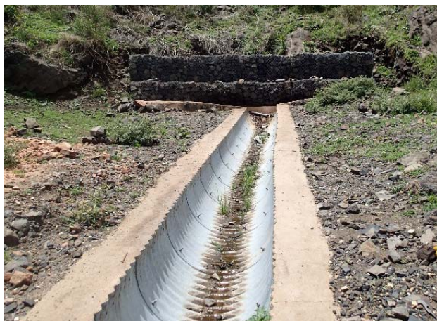
Canal con tubo de acero corrugado
