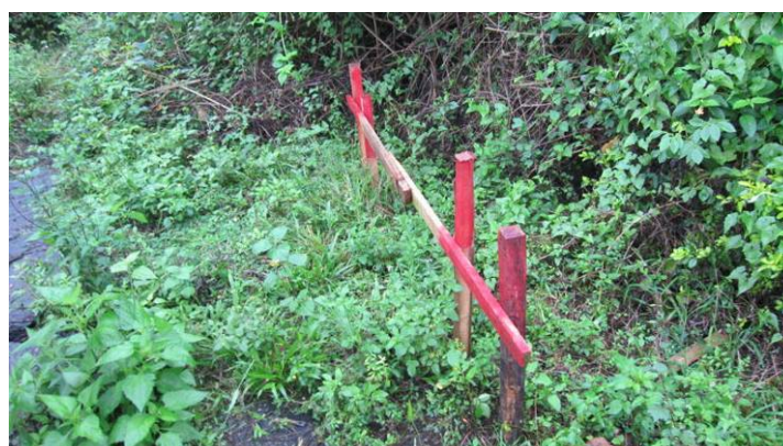
Figura 1.6.2 Ejemplo de instalación de estacas de desplazamiento (Fuente: JCT)
