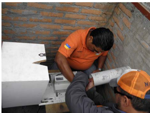
Inspección del registrador de datos y alambre de invar
