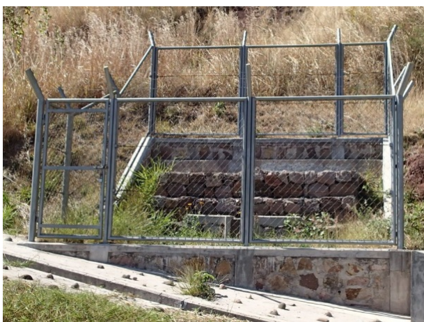
Gabion工による孔口保護壁
