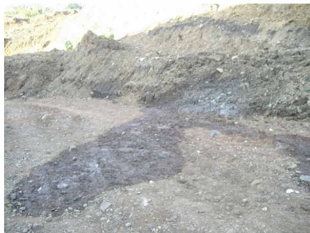
切土のり面からの湧水
