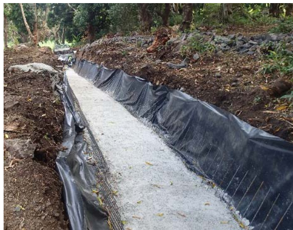
水路下への遮水シートの敷設
