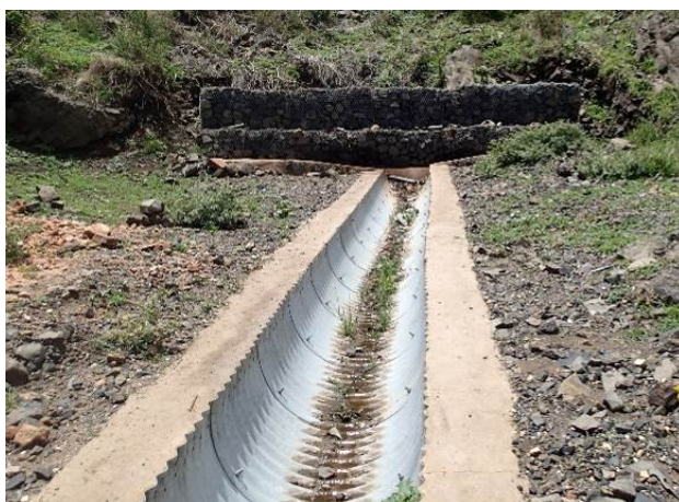
スチールのコルゲート管を用いた水路
