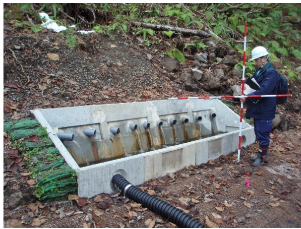
コンクリートによる孔口保護壁
