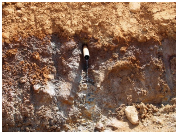
湧水箇所にPVC管を挿入
