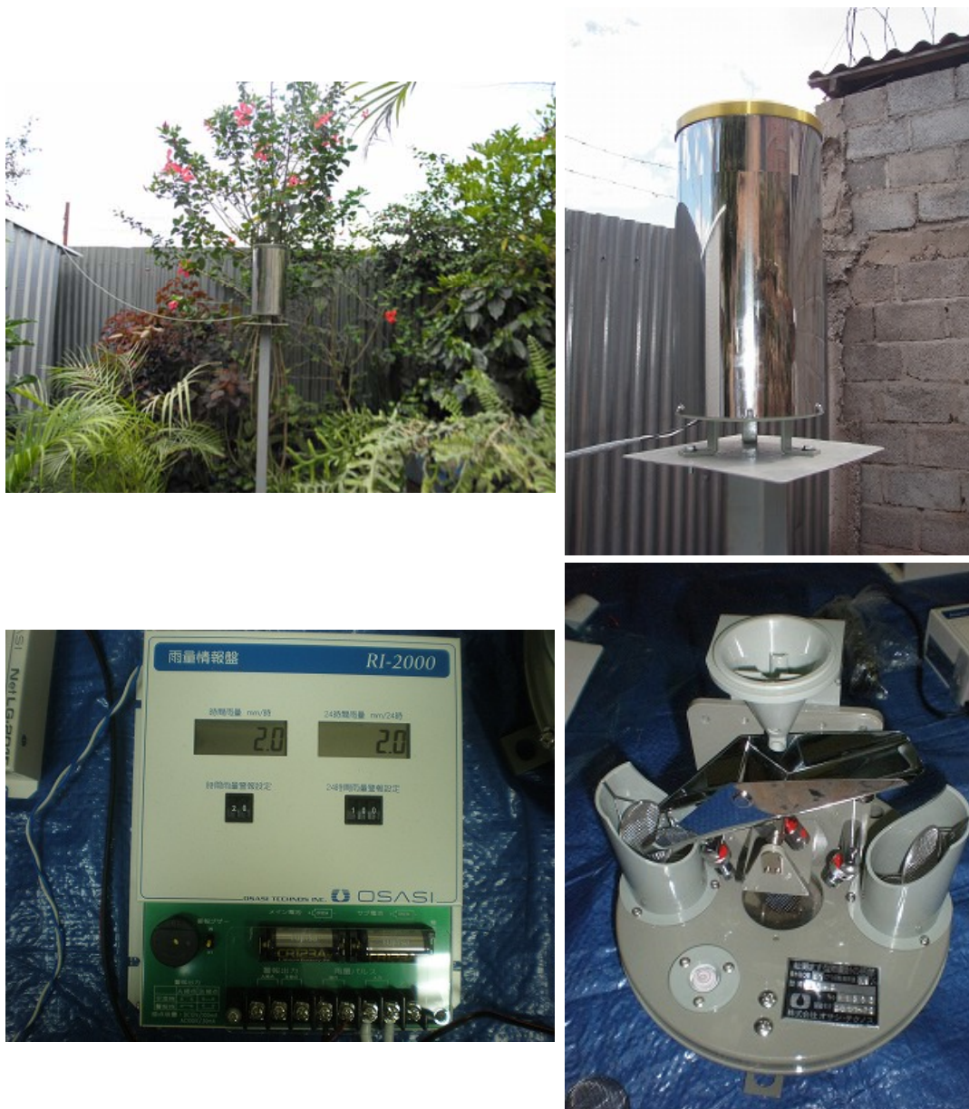
図1.5.1 Reparto 地区に設置されている雨量計（出典：JCT）
