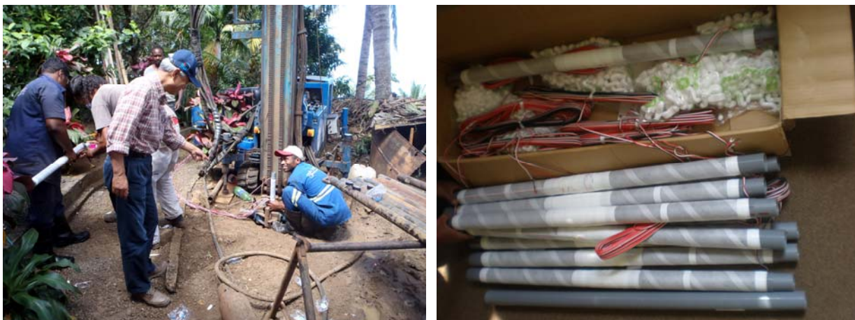
図1.7.1 パイプひずみ計の設置（左）とひずみ計（右）（出典：JCT）
