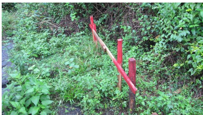
図1.6.2 移動杭の設置例 (出典：JCT)
