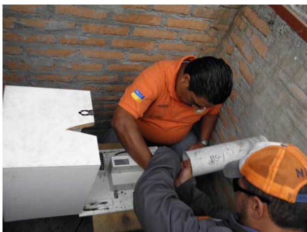
データ収録装置とインバー線の点検
