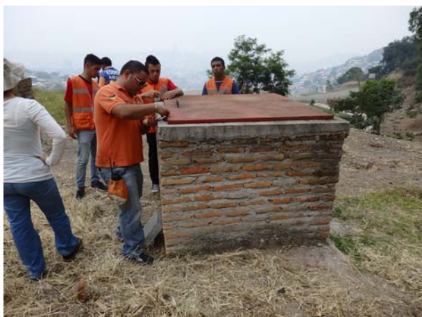
計器保護施設
