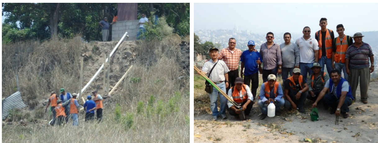
図 18 供与機材の活用(新規伸縮計の設置作業) (出典:JCT)
