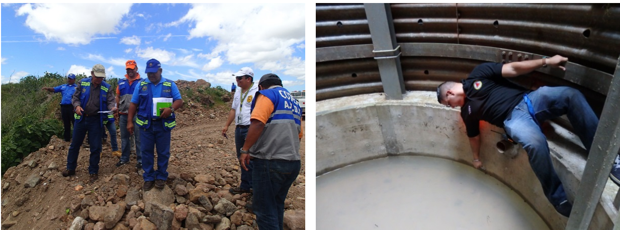
図 22 現場での協議および指導、計測（出典:JCT）
