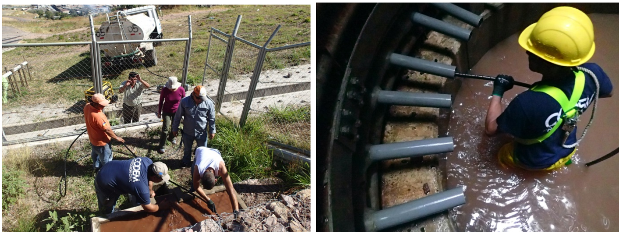
図 17 水平排水工の詰まり除去作業 (出典:JCT)
