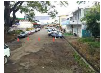
写真 18-3 左岸現道状況
