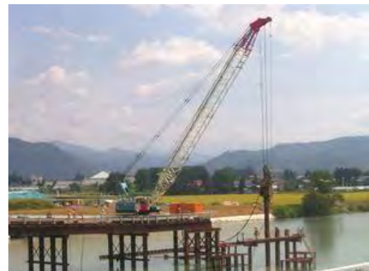
仮橋の施工事例
