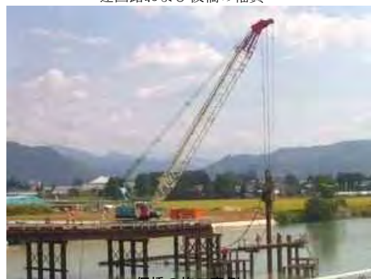
仮橋の施工事例
