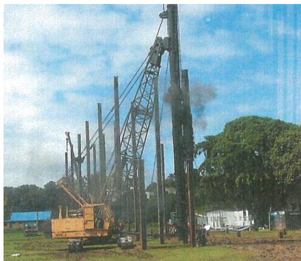
図 18-68 基礎杭施工事例（ディーゼルハンマによる杭打設）
