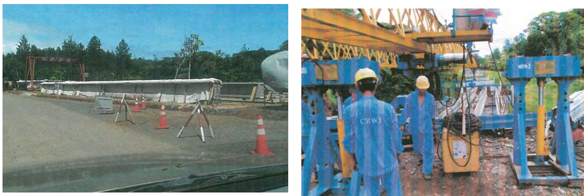
図 18-69 架設桁架設施工事例
