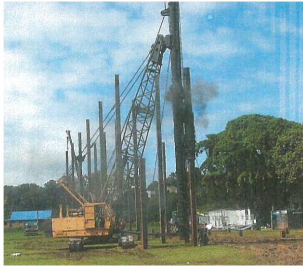
図 18-80 基礎杭施工事例（ディーゼルハンマによる杭打設）
