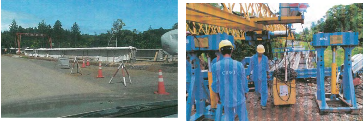
図 18-81 架設桁架設施工事例
