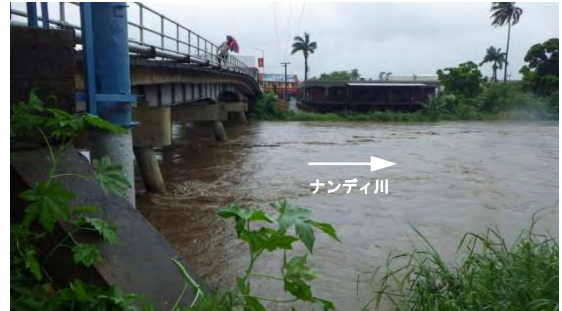
写真-10 ナンディ川 (Nadi Town Bridge) / 洪水時
