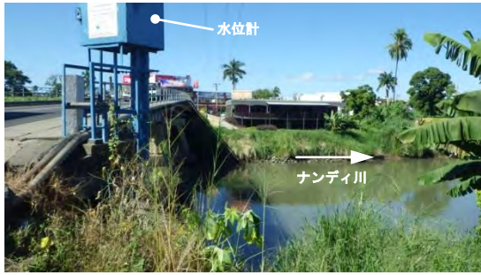
写真-9 ナンディ川 (Nadi Town Bridge)
