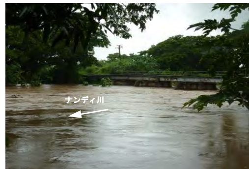
写真-12 ナンディ川 (Old Queens Road Bridge) / 洪水時
