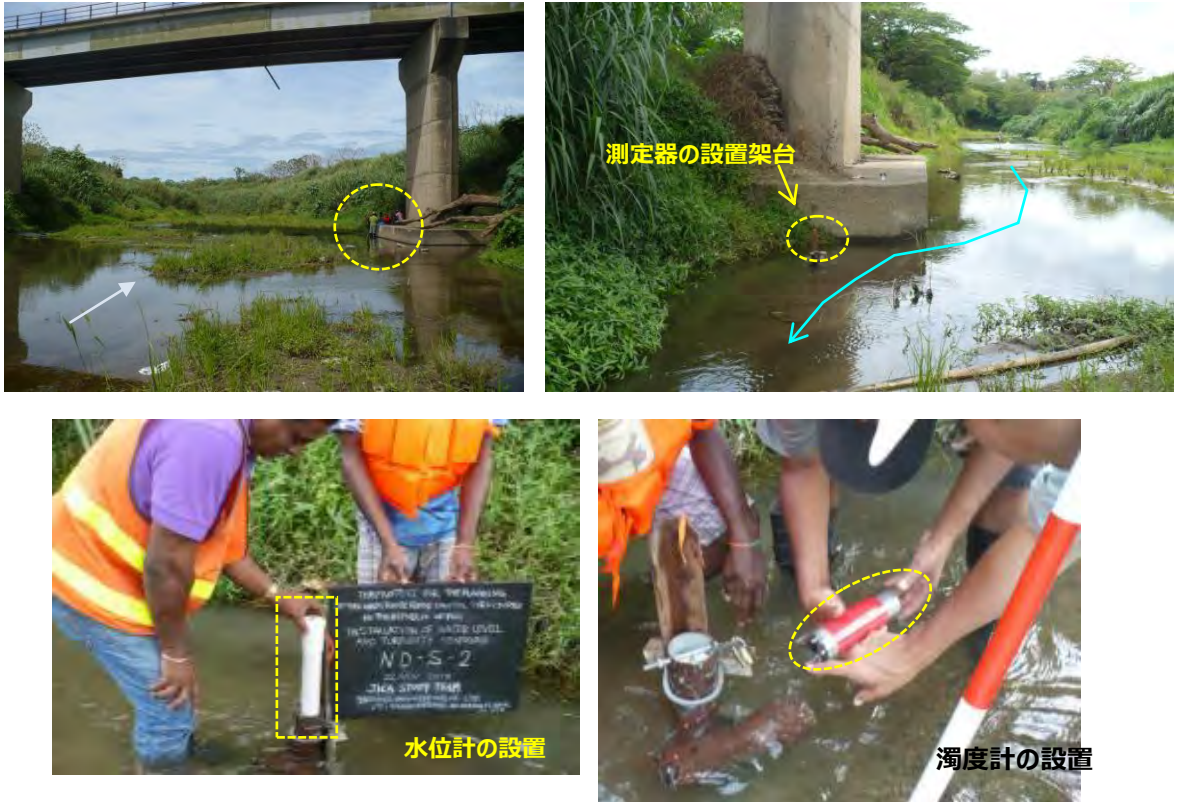
写真 9-4 観測機器の設置状況（ナンディ本川、バックロード・ブリッジ）
