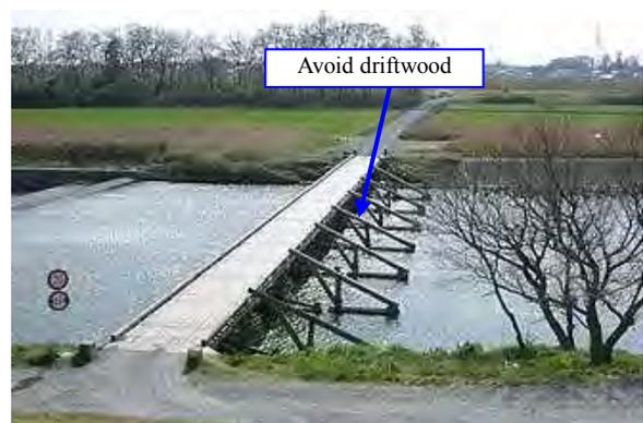
図 8-63 流木衝突リスク低減対策事例 2
