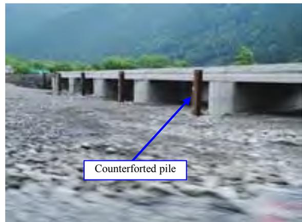
図 8-61 流木衝突リスク低減対策事例 1
