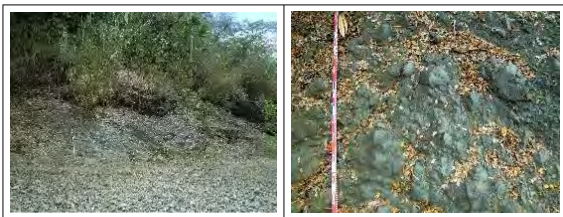
写真-2 NAD-1 河床部の地質および岩盤状況
