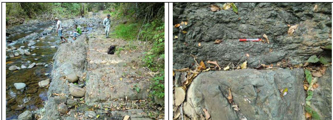
写真-14 NAW-1 河床部の地質および岩盤状況
