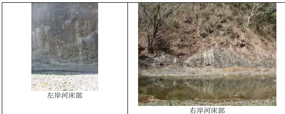
写真-8 NAD-4 河床部の地質および岩盤状況
