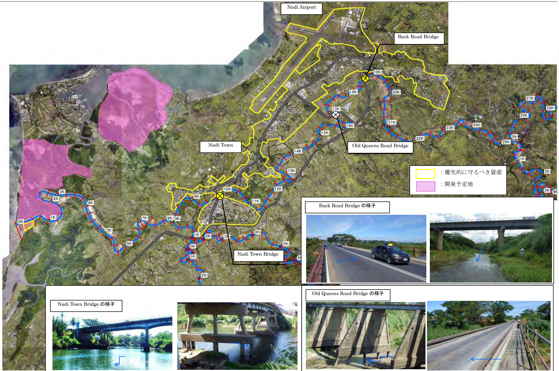
図 6-4 優先的に守るべき資産および橋梁の状況
