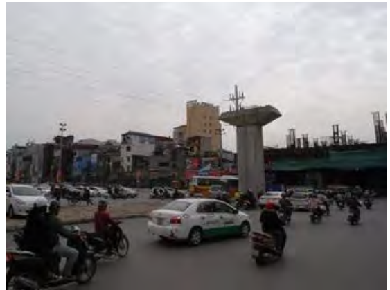
ハノイ市都市鉄道 2A 号線の建設現場
