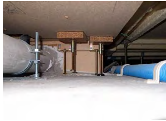
Hình 2 Hệ thống đường ống dưới sàn nâng hai lớp
