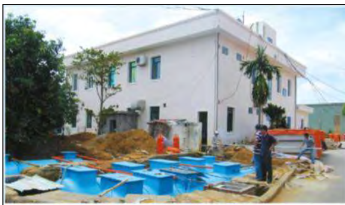
Hình 7-32 Cụm bể xử lý nước thải tại chỗ bằng nhựa composite
