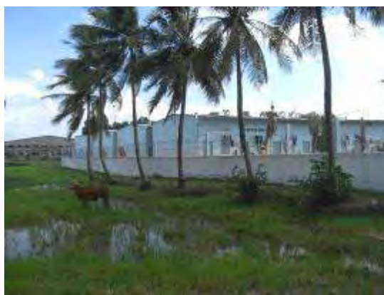
Nhà thấp tầng ở khu đất rộng gần KCN Long Thành
