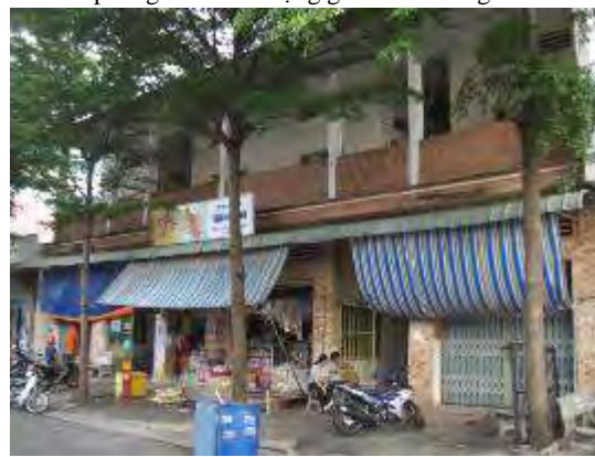
Nhà thấp tầng có cửa hàng tầng trệt tại KCN Mỹ Phước
