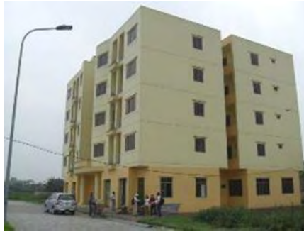
図 3-7 入居率が低いため単身者用寮から家族用住戸へ改修された事例（ダイアン工業団地）
