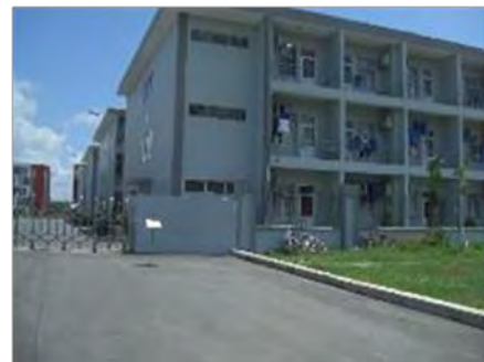
図 3-4 工業団地に設置されている労働者寮の事例
