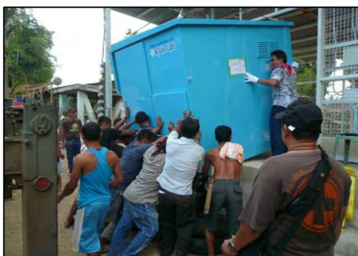
アクア・キューブの設置作業 (2015年5月25日)
