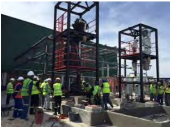
プラント据付 (2015年10月)
