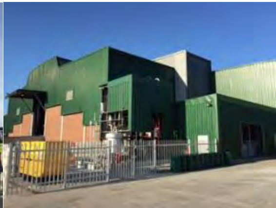
現地工事完了 (2015年10月23日)
