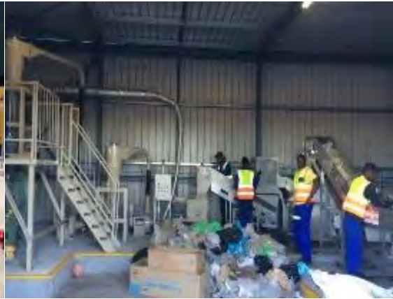
実証運転（フルロードテスト）の様子 (2016年3月25日)
