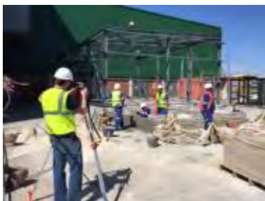
鉄骨・防油堤工事
