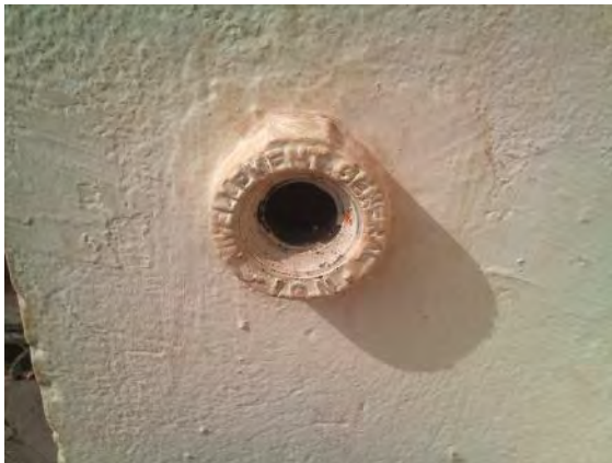
Un repère de nivellement existant
