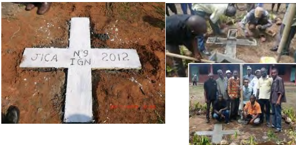
Photos 2-8 La mise en place des signaux aériens
