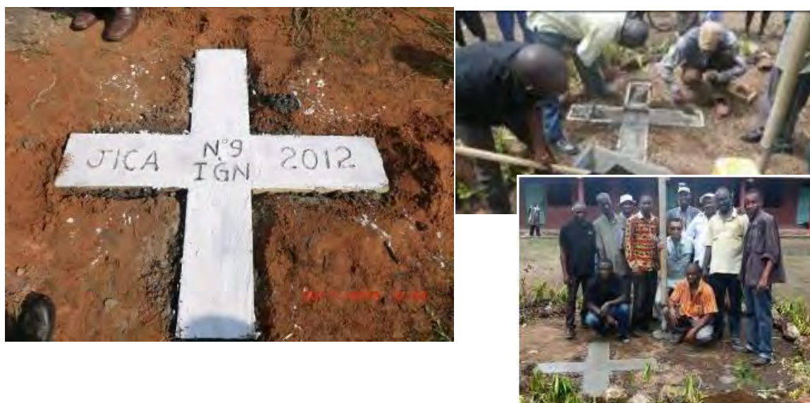
Photos 2-1 La mise en place des signaux aériens
