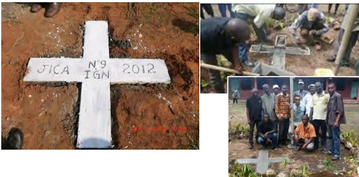
写真 2-1 対空標識の設置風景
