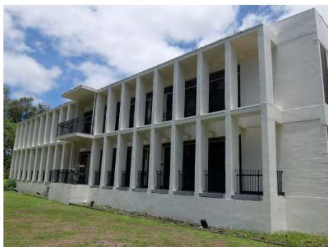
写真-5： 我が国が2000年に供与した訓練・教育センター（TEC）。その他の既存棟と同じく定期的なメンテナンスが行われている。
