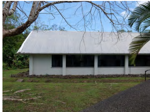
写真-2： SPREP 本部敷地内の既存建物。2000年に建設され、定期的に塗装等のメンテナンスが行われている。
