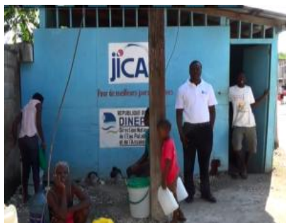
(Photo : une fontaine restaurée de Léogane)
