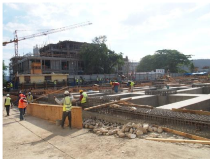
(Photo : l'hôpital de Jacmel en construction)
