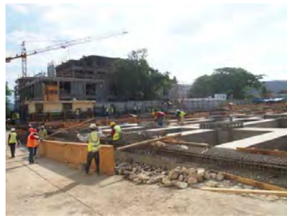
(写真：建設中のジャクメル病院)
