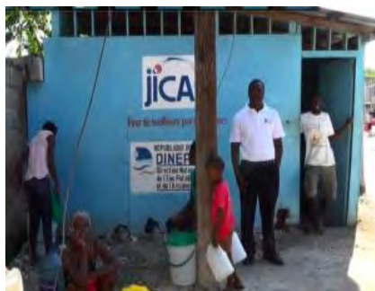
(写真: 修復されたレオガン市の給水所)
