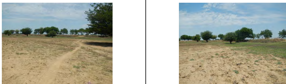
Photos 8-12 Amoncellement de terre qui semble être une digue, sur la rive droite de fleuve Koumongou
