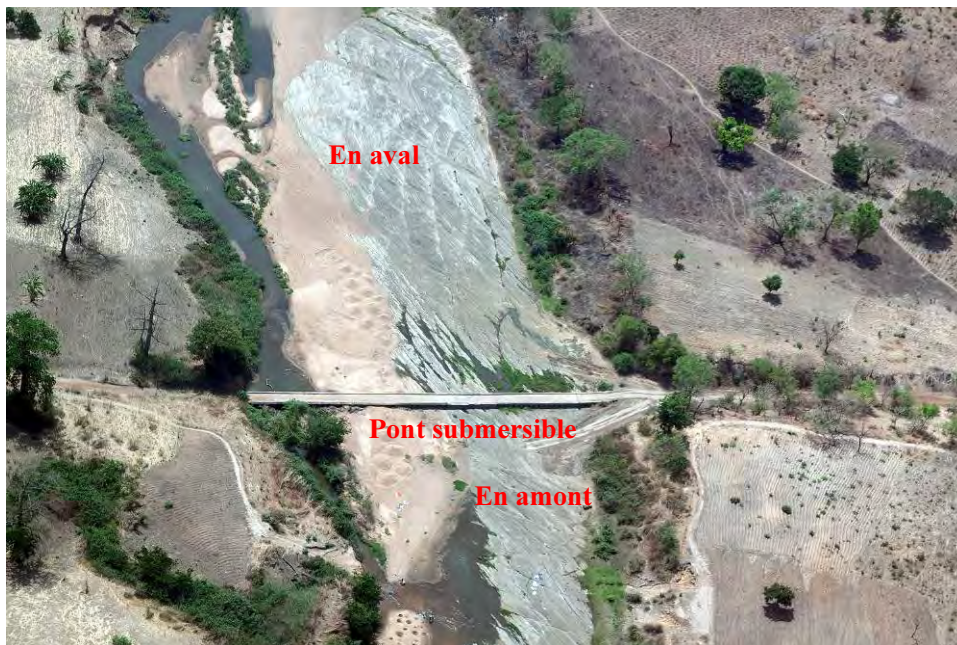
Photo 8-5 Vue aérienne du point de construction du pont sur le fleuve Kara avec pont submersible
