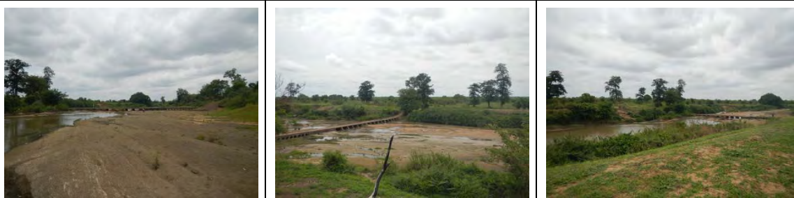
Photos 8-6 État du cours d'eau aux environs du point de construction du pont sur le fleuve Kara
