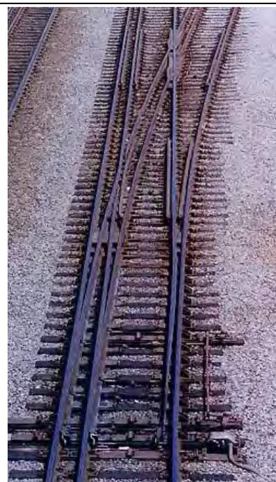
Photo 7-1 Aiguillage pour voie à double écartement
