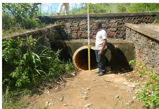
Pipe Culvert (Km 283.6)
