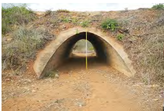
Arch Culvert (Km 328.8)
