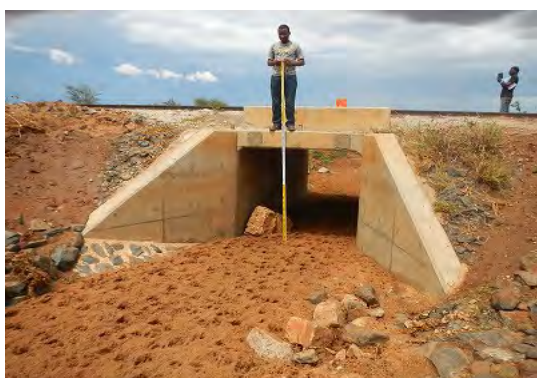
Box Culvert (Km 349.8B)
