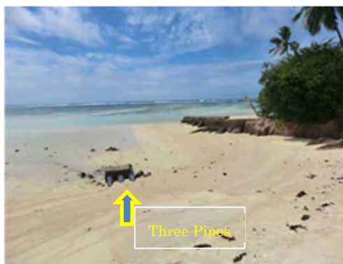
図 6-6-16 パイプによる排水状況（2012年）
