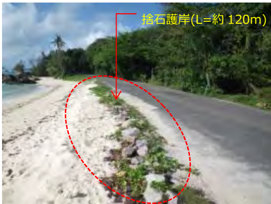
写真 2-4-9 ノース・イースト・ポイントの捨石護岸
