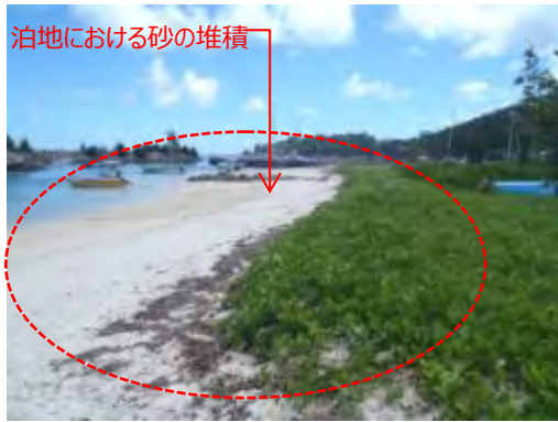
写真 2-4-6 ラ・パッセでの泊地での堆積と侵食による樹木の倒壊
