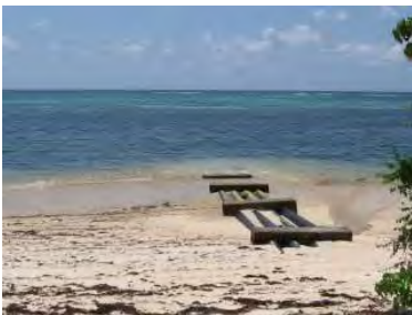
写真 5-2-25: 管路により排水される吐口 C (April 2011)
