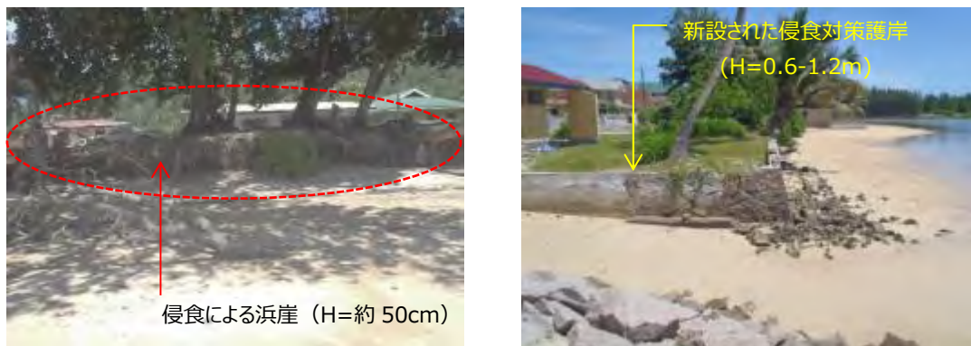
写真 2-4-2 アンセ・オ・ピンの侵食海岸(左:浜崖が見られる、右: 市場の前面に侵食対策として造られた護岸)
