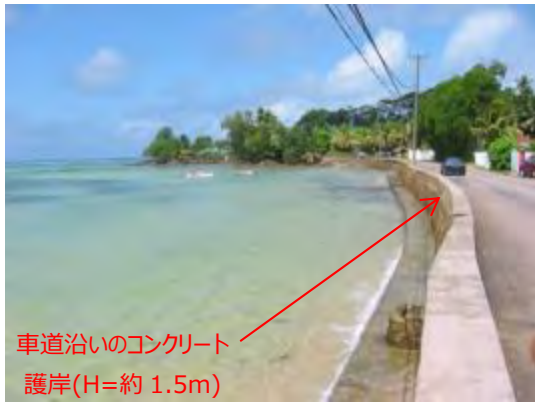
写真 2-4-7 オ・カップのコンクリート護岸
