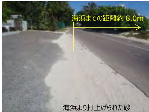
写真 2-4-1 ノース・イースト・ポイントの道路への砂の打ち上げと海岸の侵食状況
