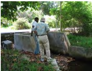
写真 5-2-26: 管路の呑口 (April 2011)
