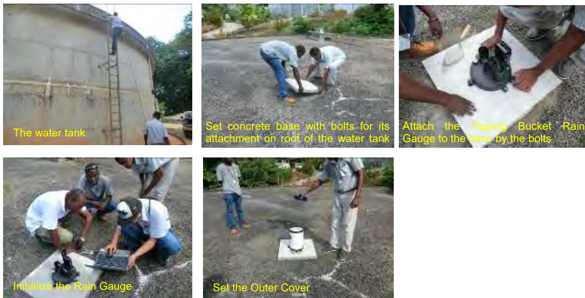
図 2-5-5 雨量計設置状況 (ヘミテージ、PUC)
