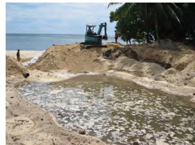
写真 5-2-27: 改修中の吐口 C (Jan 2014)
