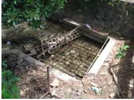
写真 5-2-17: 湿地からの排水口 (May 2011)
