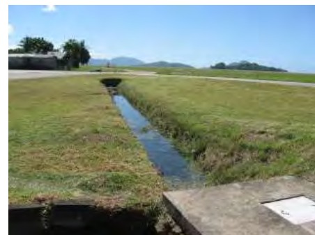
写真 5-2-16: 空港内の排水路 (C) (April 2011)
