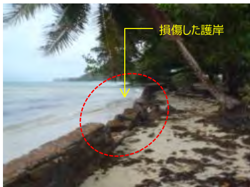
写真 2-4-3 アンセ・ロイヤルの損傷した護岸と散乱した護岸の玉石
