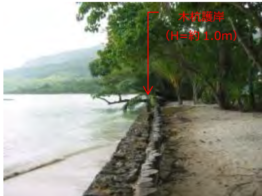
写真 2-4-8 アンセ・ボアルーの木杭護岸
