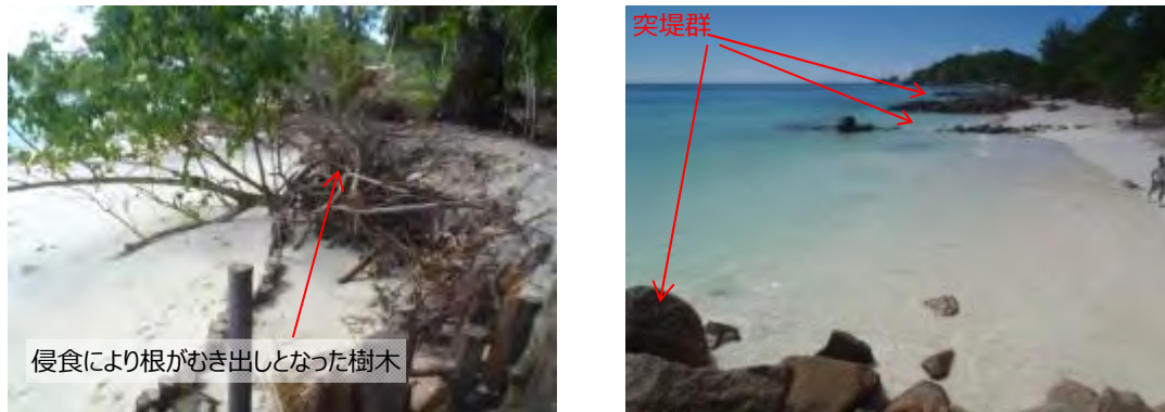
写真 2-4-5 アンセ・ケランにおける侵食状況と突堤群
