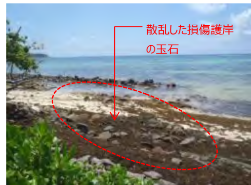
写真 2-4-3 アンセ・ロイヤルの損傷した護岸と散乱した護岸の玉石
