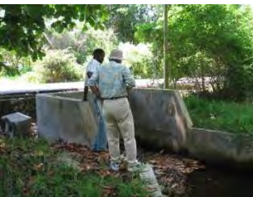
写真 5-2-14: 管路の呑口 (April 2011)
