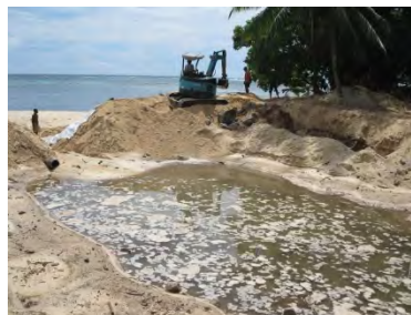
写真 5-2-15: 改修中の吐口 C (Jan 2014)
