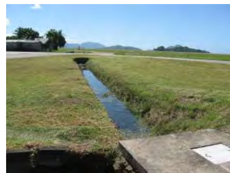
写真 5-2-7: 空港内の排水路 (C) (April 2011)
