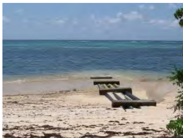
写真 5-2-13: 管路により排水される吐口 C (April 2011)
