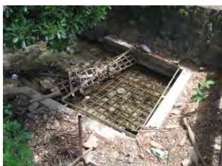
写真 5-2-8: 湿地からの排水口 (May 2011)
