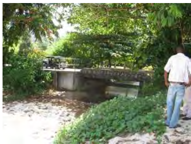
写真 5-2-9: 排水路 A の河口閉塞 (April 2011)
