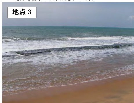
ビーチロックが露出し始めている箇所
