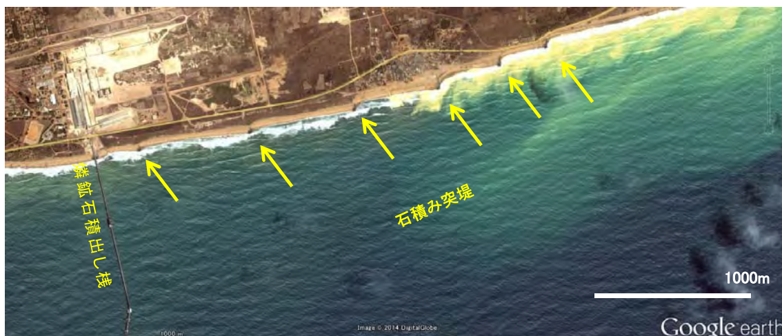
図 1-17: 燐鉱石積出し栈橋(ロメ自治港の東 26km)周辺における海岸侵食対策工
