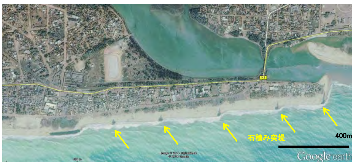
図 1-16: アネホ(ロメ自治港の東 36km)における海岸侵食対策工(石積み突堤)
