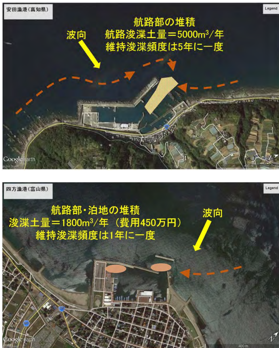
図 4-18 日本国内の漁港の堆砂事例：安田漁港 (高知県：上図)、四方漁港 (富山県：下図)
