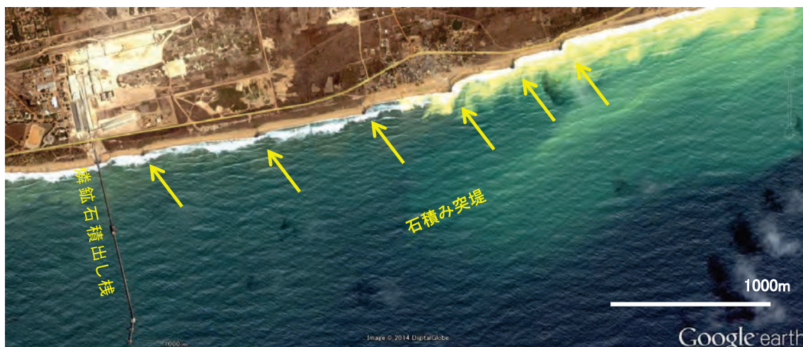
図 1-17: 燐鉍石積出し桟橋(ロメ自治港の東 26km)周辺における海岸侵食対策工
