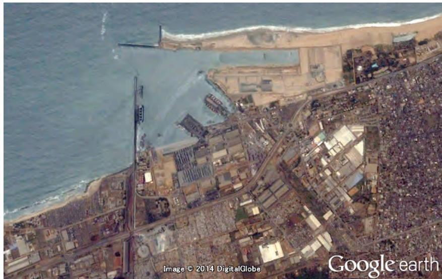
図 2-30:現在のロメ自治港西側の堆積状況(2014年)
