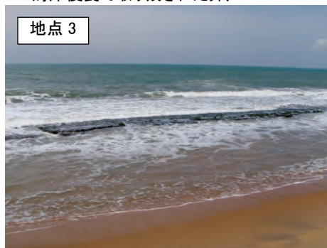
ビーチロックが露出し始めている箇所
