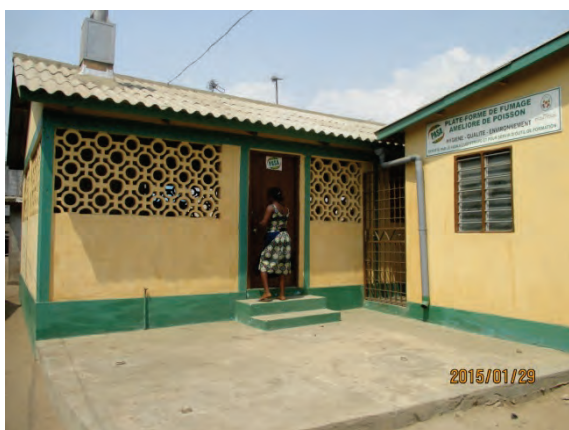
図 1-20: PASA により建設された共同加工施設
