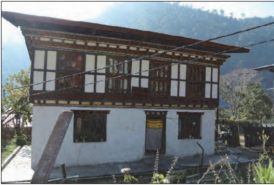
写3 農業普及員の事務所建屋、RNRセンター、モンガル県サリン郡。
