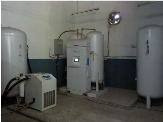
酸素製造室。製造された酸素はボンベに充填され、各病棟に届けられる。
