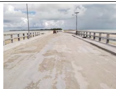
【写真-3】橋面全景 (歩道マウントアップ、縮小路肩)
