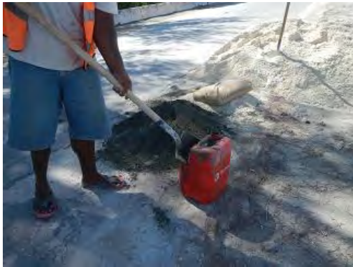
練り混ぜ状況
