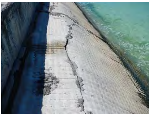
施工不良による、塗布後の剥がれ
