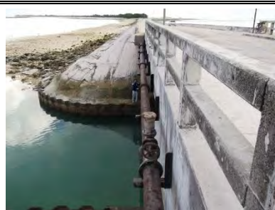
【写真-10】外洋側に添架される水道管 (漏水はなく健全)
