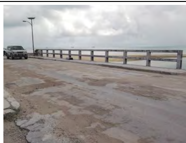
【写真-14】ラグーン側高欄 (損傷・劣化はなく健全)
