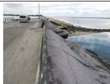
【写真-9】ベシオ側より概要側路肩全景
