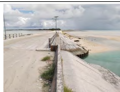
【写真-6】パイリキ側よりラグーン側路肩全景
