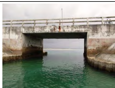
【写真-2】ラグーン側より側面全景
