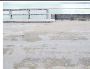
【写真-15】ボックスと取付道路の境界 (ボックス構造のため伸縮装置はない)
