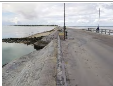
【写真-7】ベシオ側よりラグーン側路肩全景
