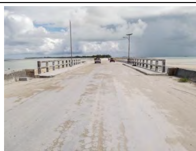
【写真-5】パイリキ側より道路中心全景
