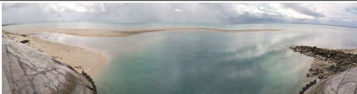
【写真-17】ラグーン側水路 (コンクリート殻による制水工がバイリキ側のみに設置されている、堆砂により干潮時の船舶の航行は困難)
