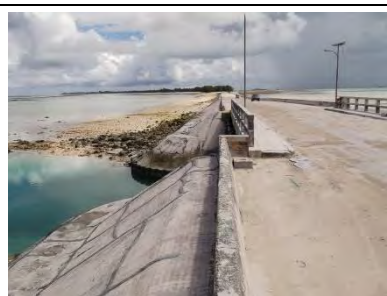
【写真-4】パイリキ側より外洋側路肩全景
