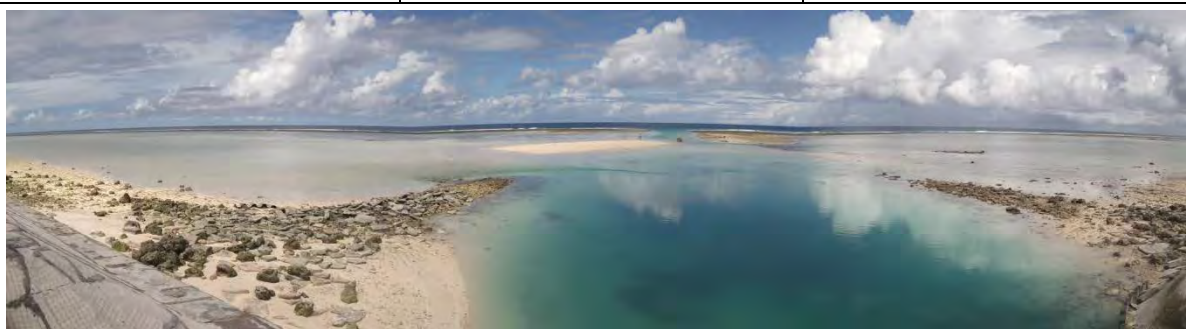
【写真-16】外洋側水路 (コンクリート殻による制水工が両側に設置されている、堆砂により干潮時の船舶の航行は困難)
