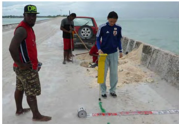
橋梁部の健全度調査状況
