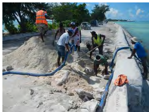
【写真3】クラック背面の砂充填作業
