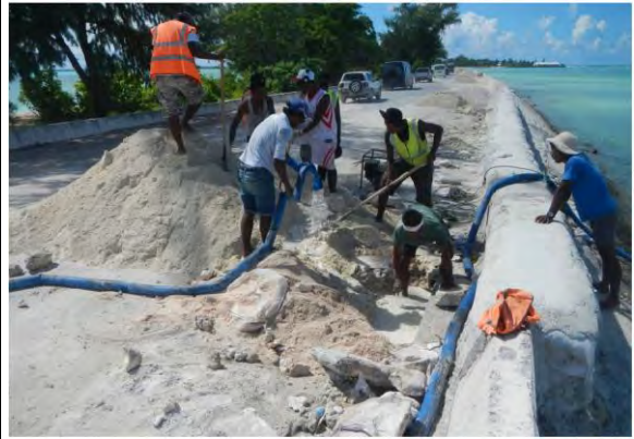
地元作業員による水締め補修状況
