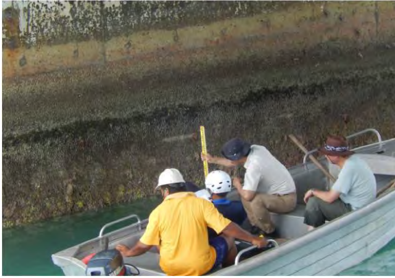
橋梁部の健全度調査状況
