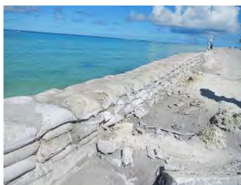
【写真4】モルタル土嚢によるパラペット構築状況
