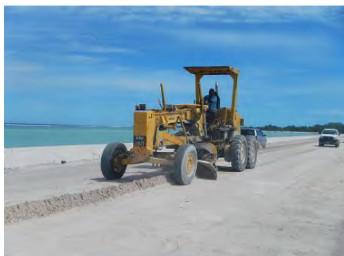
【写真1】グレーダーによるポットホールの穴埋め
