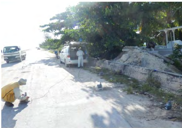
埋設物探査の状況
