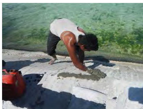
【写真2】クラック補修状況
