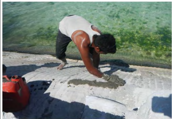
地元作業員によるひび割れ補修状況
