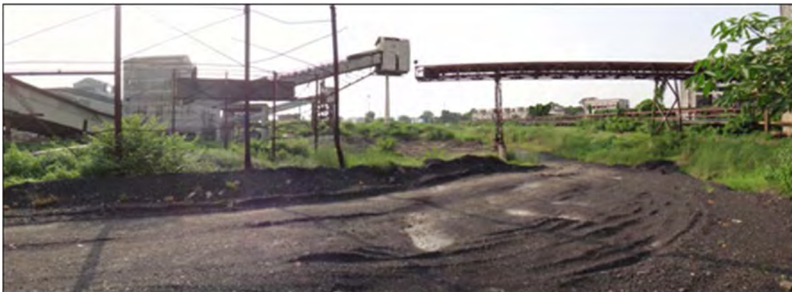
写真 4.1-6 No. 6/7 号機向け貯炭場の状況
