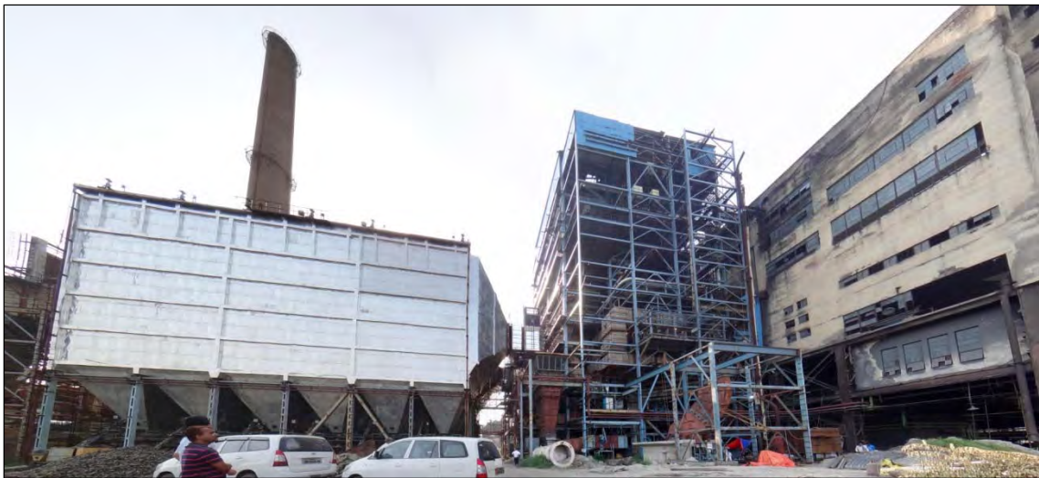
写真 4.1-4 No. 6/7 号機 R&M/LE 工事状況
