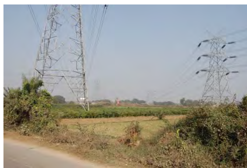
Barh Taal area 内の既存の送電線
