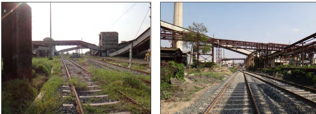
写真 6.3-1 構内鉄道（左）と整備状況（右）
