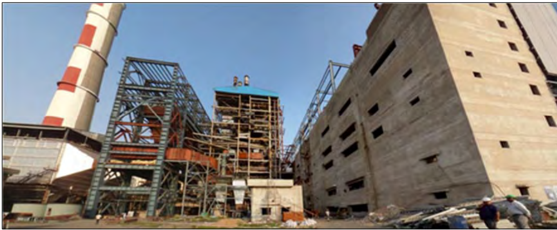
写真 4.1-5 No. 8/9 号機建設工事状況 (2015 年 9 月)
