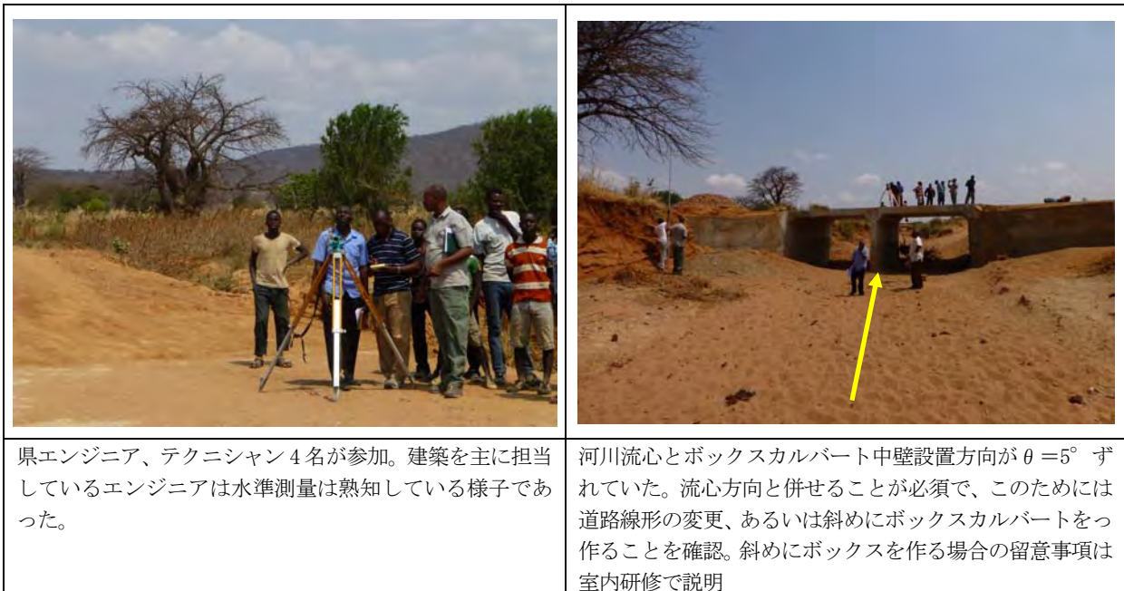
図 2-7 Chamwino 県での河川断面水準測量実習
