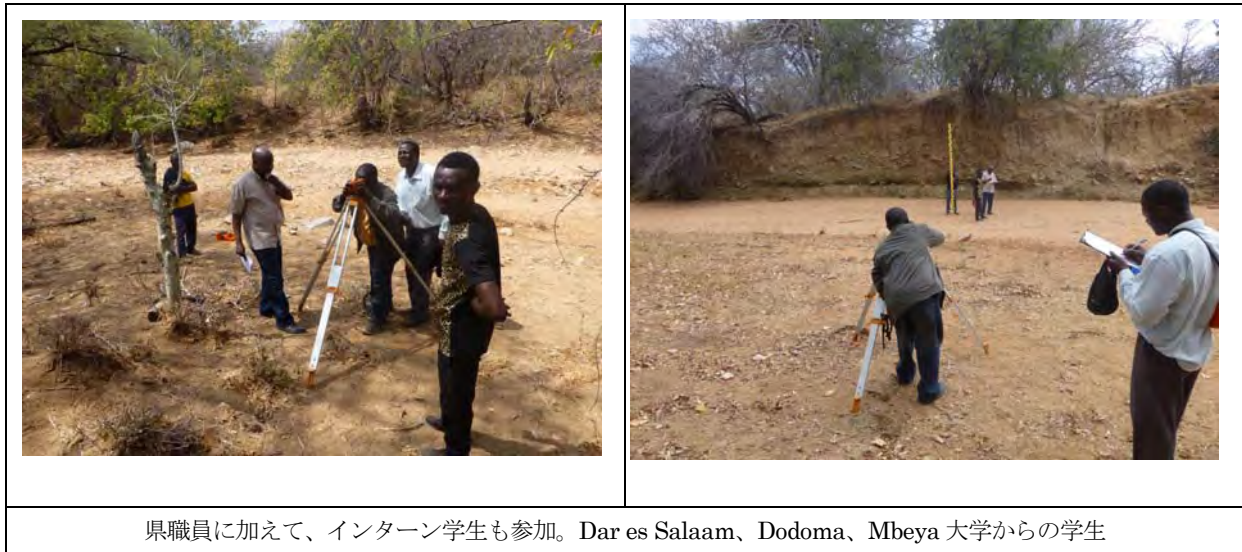
図 2-5 Iringa 県での河川断面水準測量実習
