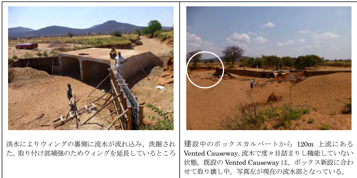
図 2-4 Chamwino 県ボックスカルバート
