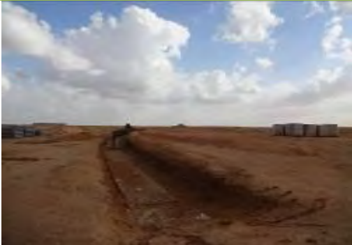
写真-1：新キャンパス建設予定地・現在造成工事中
