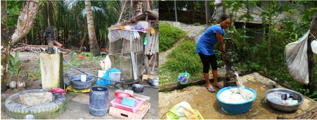
バランガイ Villafloor 内の井戸設備
