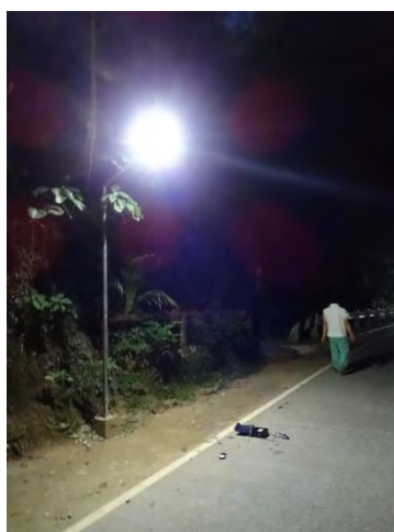
図 3.22 LED 道路灯の点灯状況
