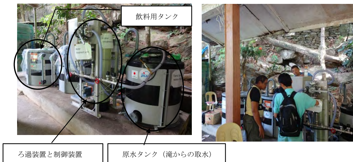
図 3.12 浄水機の設置状況と説明会の様子
