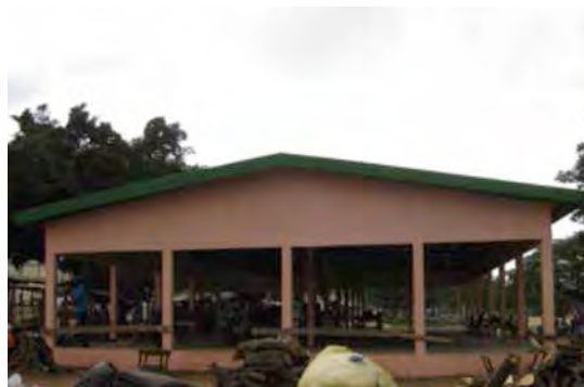
図 2-13 一時移転先建物
