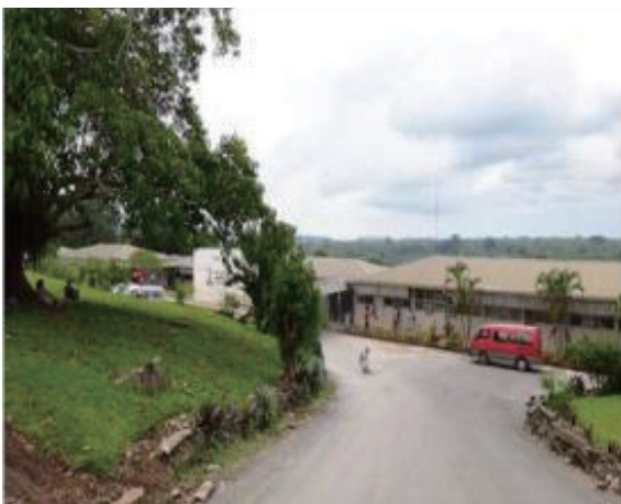
写真 3-1 改修前の病院エントランス
