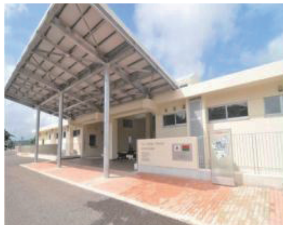
写真 3-2 改修後の病院エントランス
