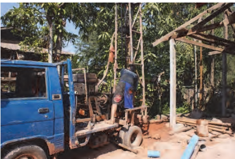
井戸掘削の様子
