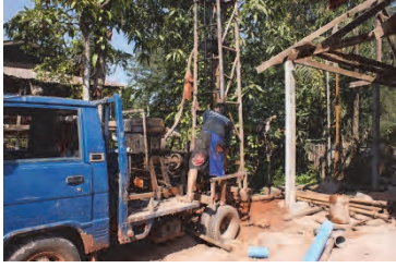
井戸掘削の様子
