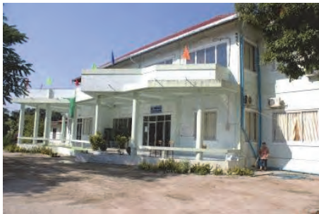
2014年に完成したLARReCの管理棟
