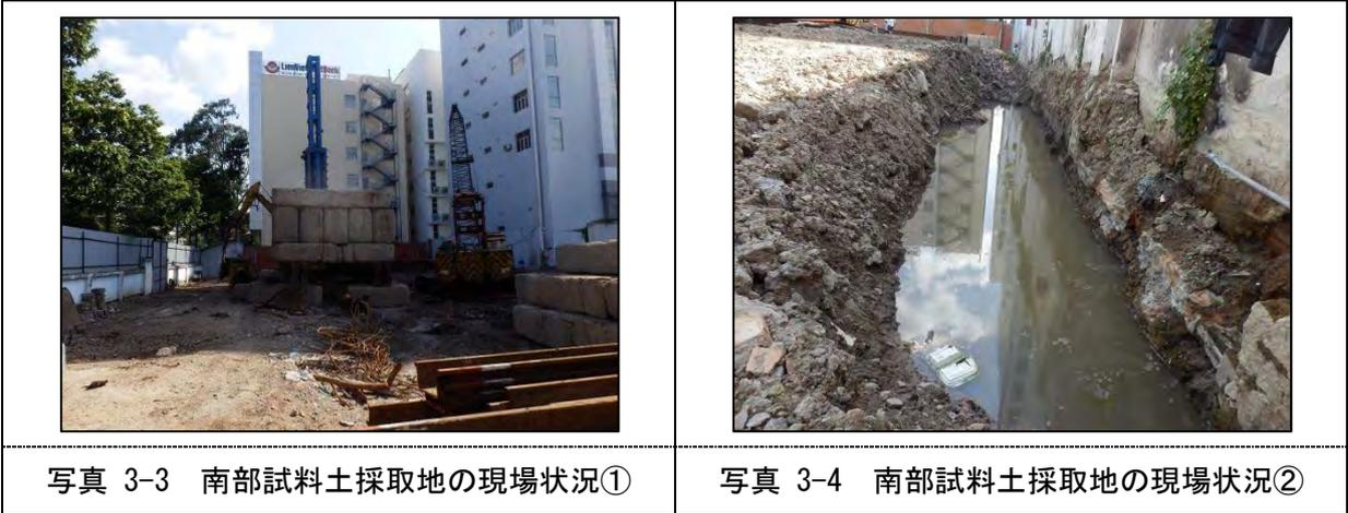
南部試料土採取地は、メコンデルタ地域の代表的な表層に厚い有機質土を含む土質で、20m 付近までは軟弱地盤な有機質土であった。建設されるビルの基礎は、40m までコンクリート杭を打ち込む必要があるような、支持層が深い地層構成とのことであった。
