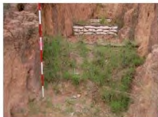
ラバカ内部の土留工。ラバカ内部に何段か施工し、土砂をせき止め、内部の勾配を安定させる。前面には張芝工を施工（2006年）
