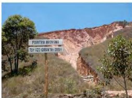
開発調査時のラバカ対策。ラバカの出口に土囊積みの土留工を施工。この付近で放牧禁止の看板も設置した（2006年）
