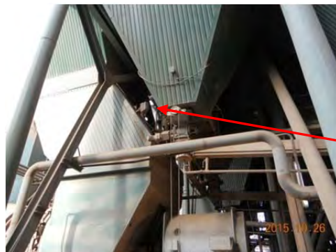
写真 3-10 ESP 出口ダスト濃度計
