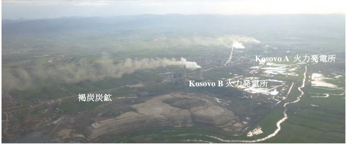
上空から見た Kosovo 火力発電所
