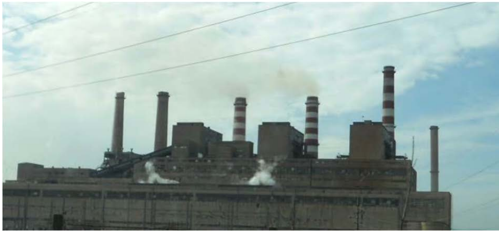
写真 6-3 Kosovo A ボイラの煙突から出る排煙
