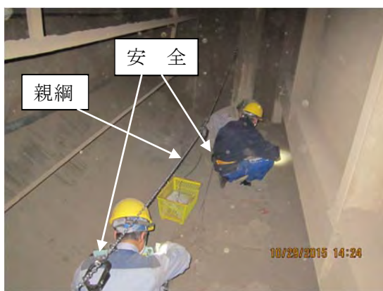
写真4-2a 入側測定の様子
