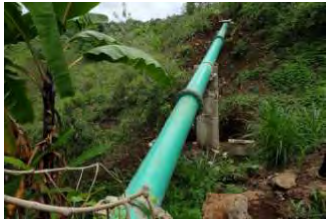
パイプライン建設工事
