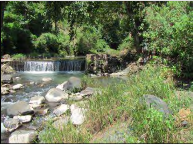
改修前の取水堰
