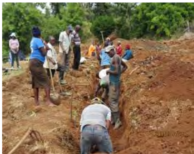
IWUA メンバーによるパイプライン掘削工事
