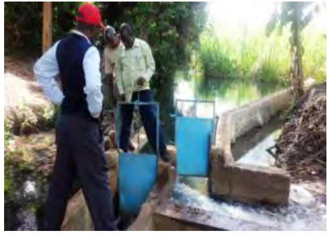
完成した取水堰
