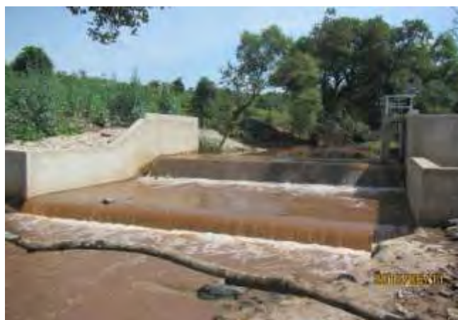
完成した取水堰
