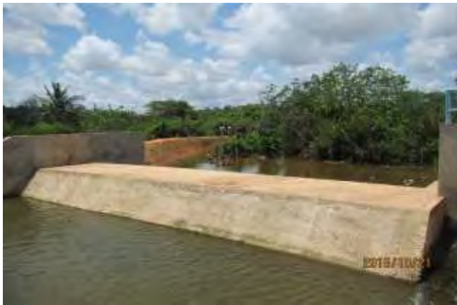
完成した取水堰
