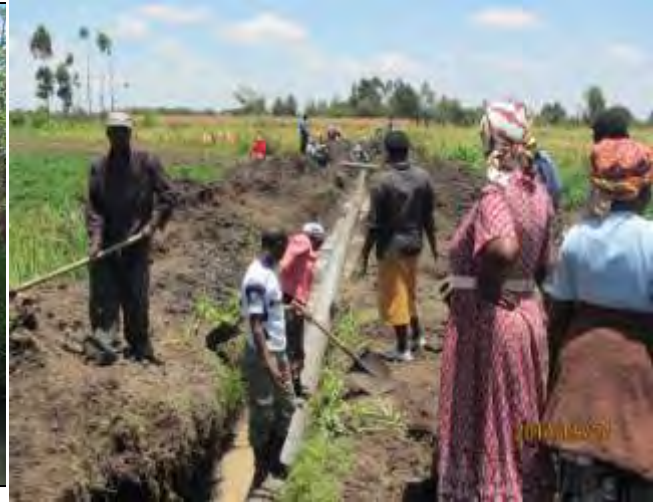
IWUA メンバーによるパイプライン布設工事
