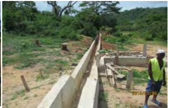
完成した幹線水路
