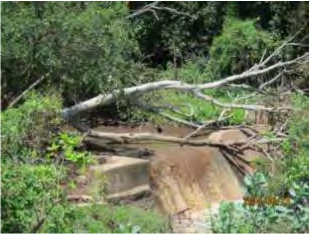
改修前の取水堰
