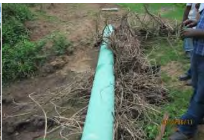
完成した導水パイプライン
