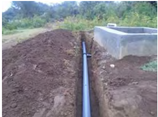
建設中のパイプライン
