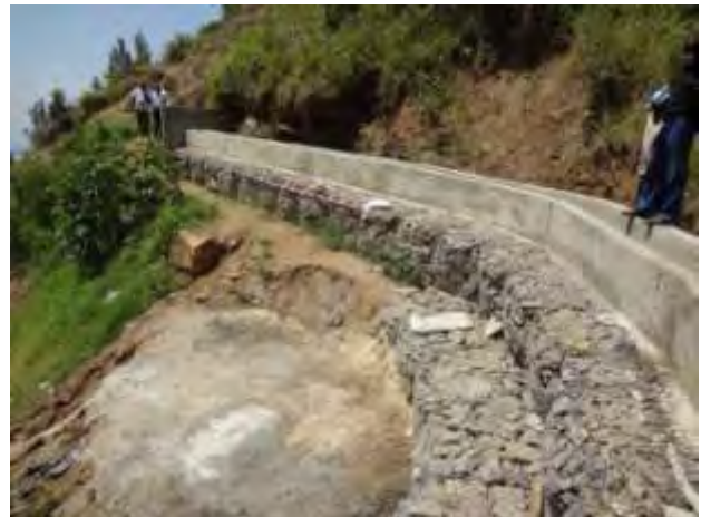
河川横断工の工事
