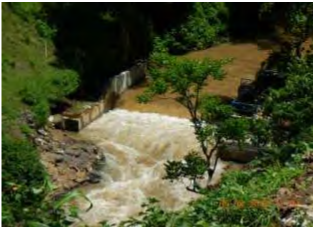
改修後の取水堰
