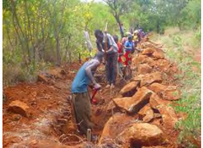
IWUA メンバーによるパイプライン建設工事
