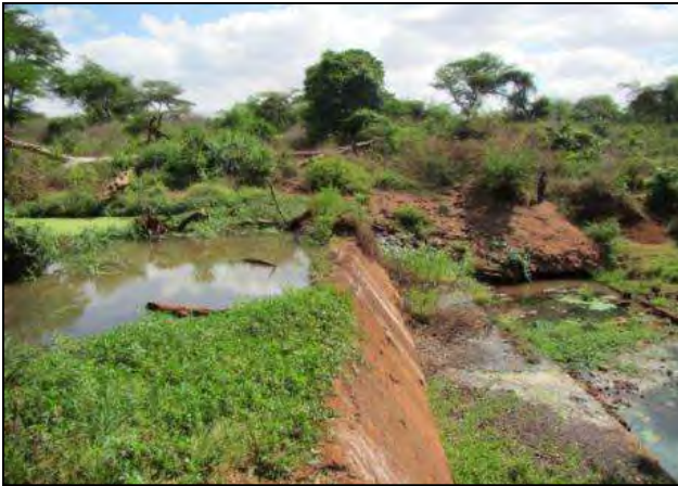
改修前の取水堰
