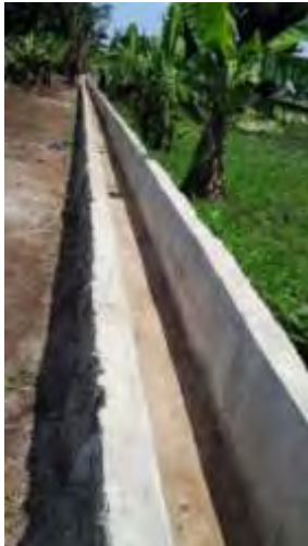
完成したライニング水路
