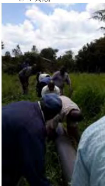
IWUA メンバーによるパイプ布設工事
