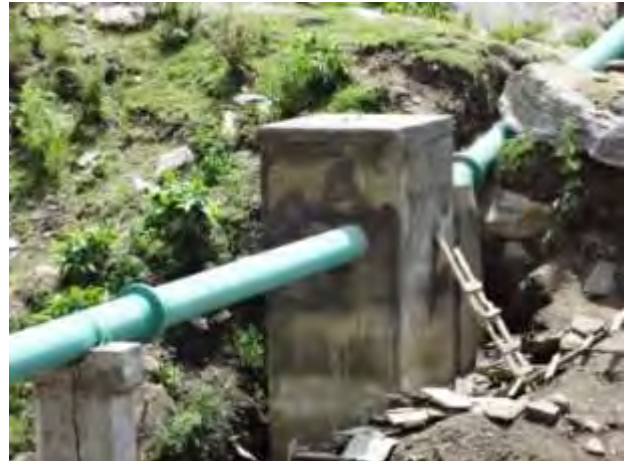
河川横断工工事
