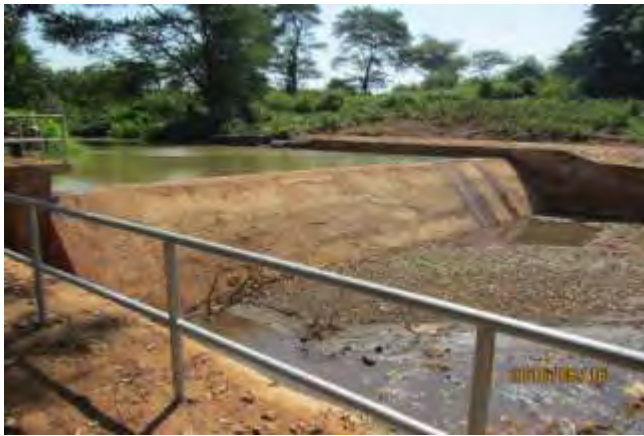
改修後の幹線水路
