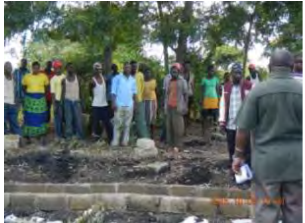
IWUA メンバーによる幹線水路ライニング工事
