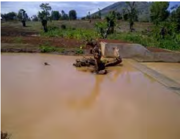
完成した取水堰
