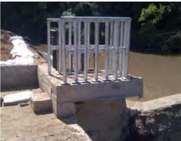
改修後取水堰
