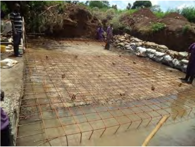
建設中の取水堰
