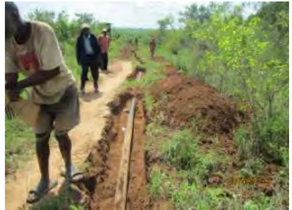
建設中の幹線パイプライン
