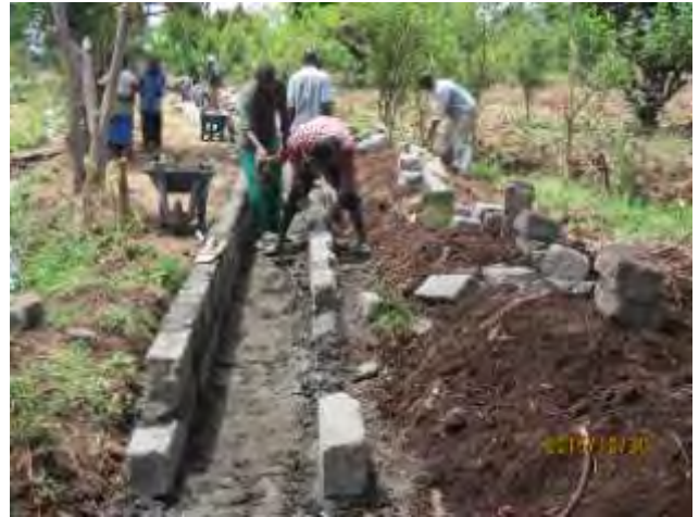
IWUA メンバーによる水路ライニング工事
