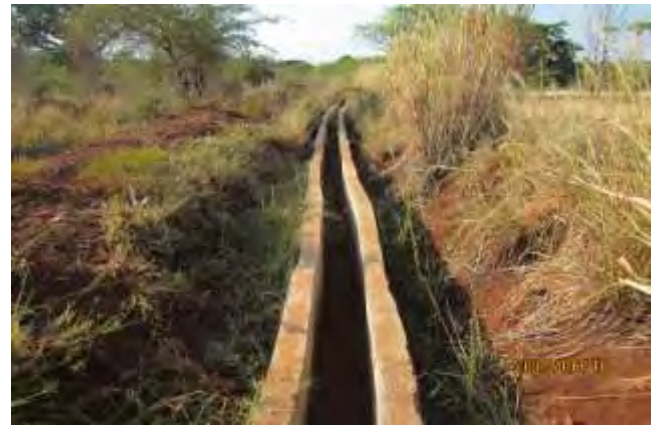
改修後の幹線水路
