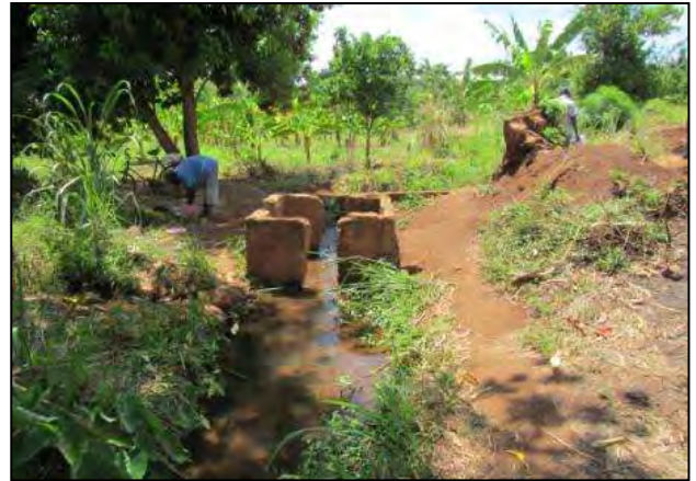
改修前の幹線水路
