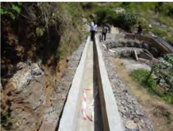
水路ライニング工事
