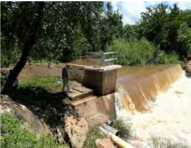
改修後の取水堰
