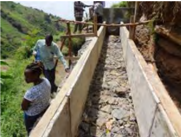
河川横断工の工事
