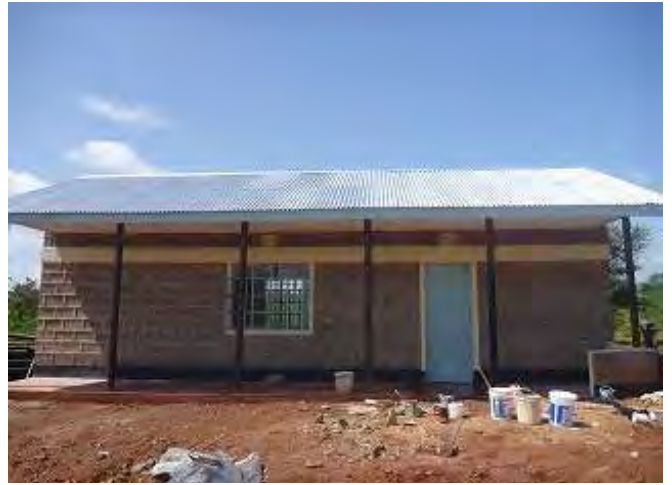
建設中の IWUA 事務所
