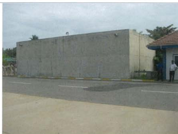
写真 1-2：港内の船舶用清水貯蔵タンク。漁船や浚渫船等に飲用清水を補給。SLCG はタンクの左隣にある施設から給水及び給電。
