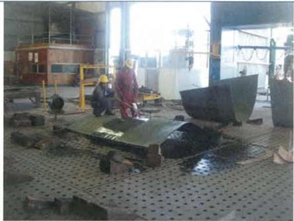
写真 4-4：曲げ加工中のコロombo・ドックヤードの船体工場。鋼製及び軽合金製の高速艇の輸出実績があるが、ハイブリッド製の船体建造実績はない。
