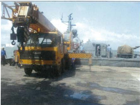
写真 4-9: トリンコマリの SLN にある MTU 専用整備場前のモービルクレーン。船を岸壁に接岸させ機関室から直接エンジンを吊上げ整備場に搬入する。
