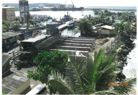
写真 3-2：SLN のスリップウェイ施設。横に 5 列見えるのは増設中の横移動式船台。2015 年 3 月完成により同時に 2 隻の船舶修繕作業が可能となった。
