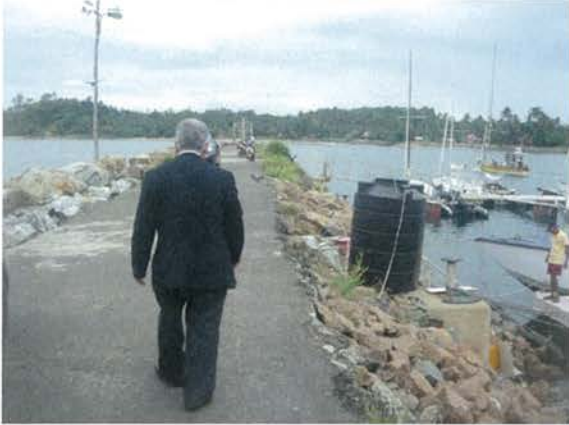
写真2-3：港内のSLCG所属船艇用の埠頭。このように防波堤のまま、岸壁が整備されていないため、給油や給水作業が不便となっている。
