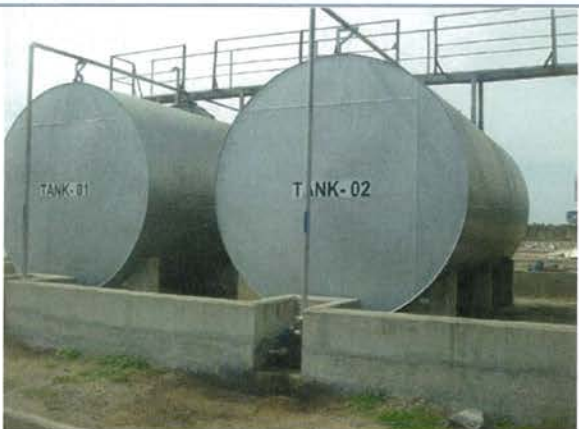
写真 1-3：港内の船舶用燃料タンク。漁船や浚渫船等にディーゼル燃料を補給。SLCG は都度タンクローリーで IPC に給油。
